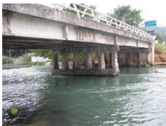
Foto 1: Vista inferior da ponte.
