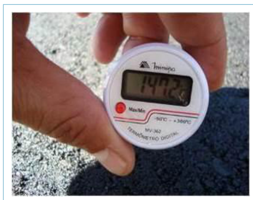
Figura 28 – Verificação da temperatura na massa asfáltica
