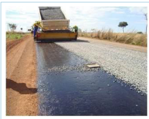
Figura 26 – Controle de taxa de agregado no tratamento superficial
