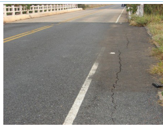
Foto 4 - Trincas longitudinais
